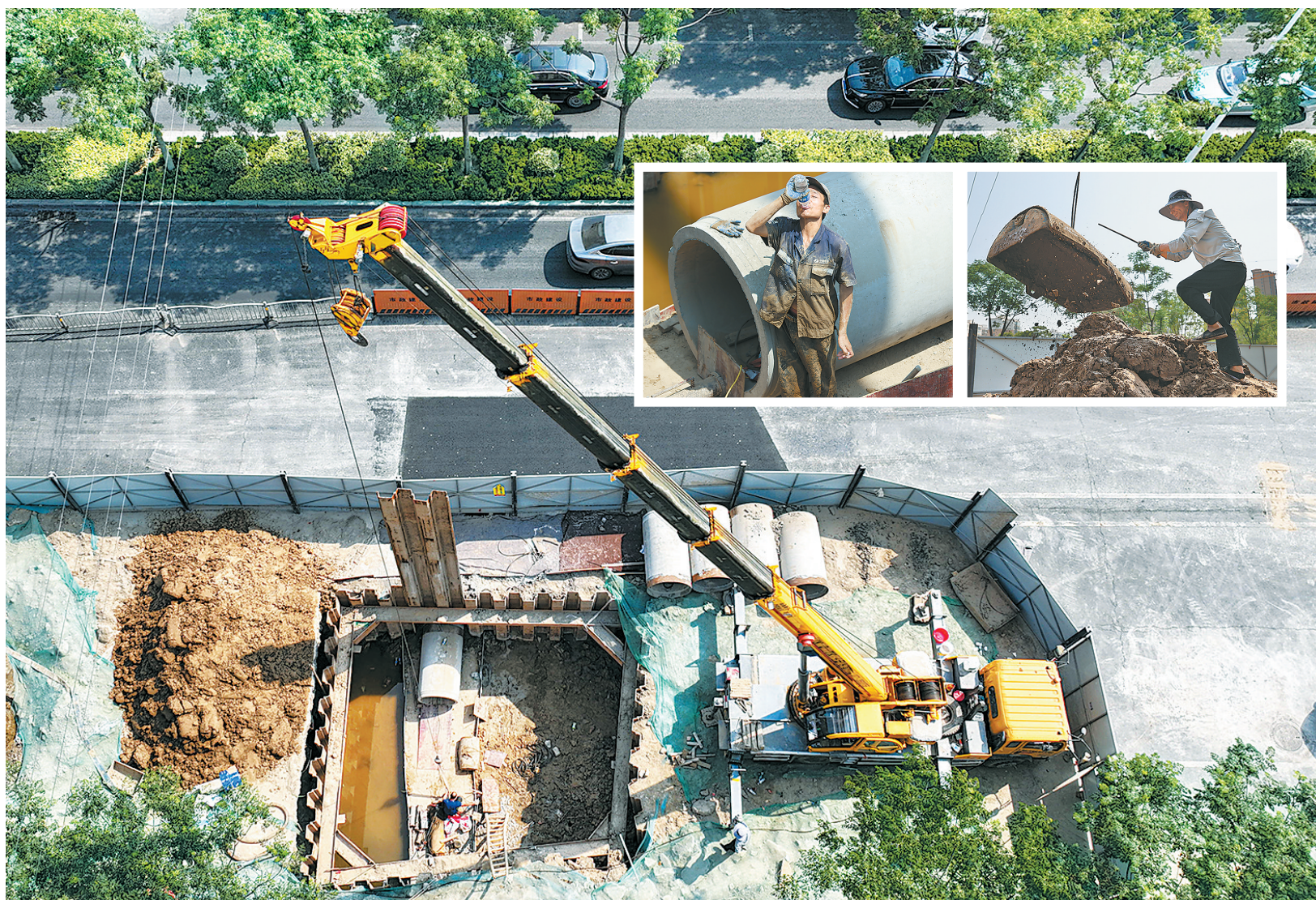
6月11日上午,在睢阳大道与民主路交叉口西侧的积水点改造施工现场,工人正冒着高温作业。商丘市气象台6月11日9时50分继续发布高温橙色预警,预计今天白天我市市区及所辖乡镇最高气温将起37℃,其中12日至13日,部分地区将起40℃。提醒市民注意防范高温天气对户外作业及出行带来的不利影响。本报融媒体记者 魏文慧 摄
