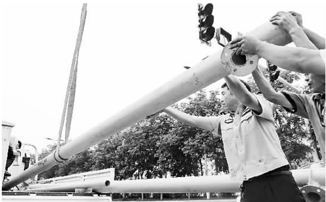
昨天上午,市交警支队交通设施大队正在神火大道南段对路口的红绿灯进行升级改造。按照省里的统一部署,交通信号灯采用统一灯型,智能标准灯联控,消除一个红绿灯只能控制一个路口的弊端。 晚报首席记者 魏文慧 摄
