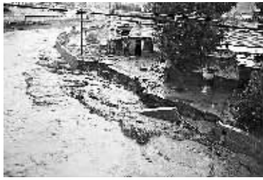
8月15日,洪水将一处堤坝冲毁。
