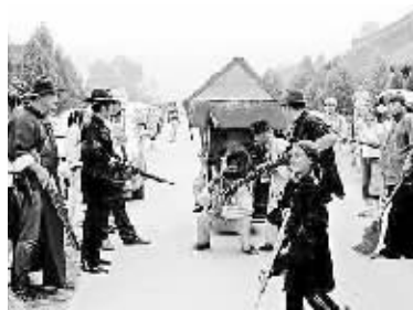
正在进行的土匪抢亲项目。
