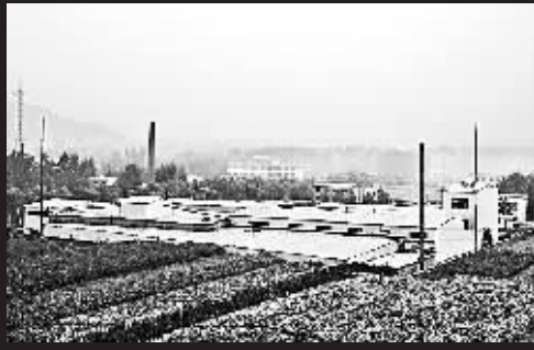
济南格林生物能源有限公司用地沟油炼制食用油的“黑工厂”坐落于济南市平阴县玫瑰镇刁山坡村西侧(9月2日摄)。
