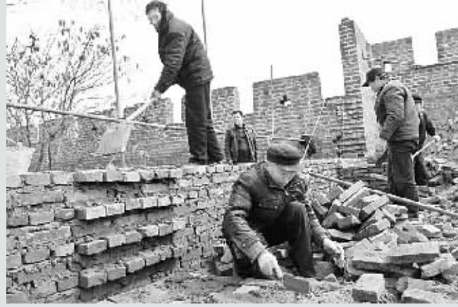
**本报讯** 昨日上午，记者在商丘古城东门的城门台上看到，几十名工人有的运送建筑材料，有的清理碎砖块，有的垒砌城墙……他们正在对城门台实施保护性维修(如图)。
