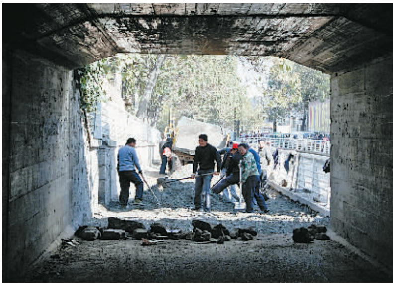
昨日,工作人员正在中州路地下道施工现场忙碌。
