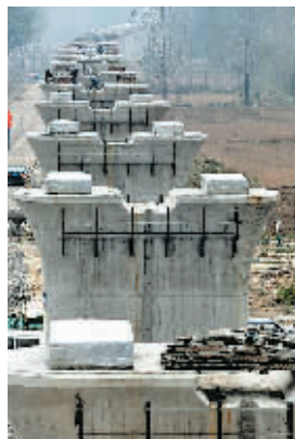
郑徐高铁正在施工
