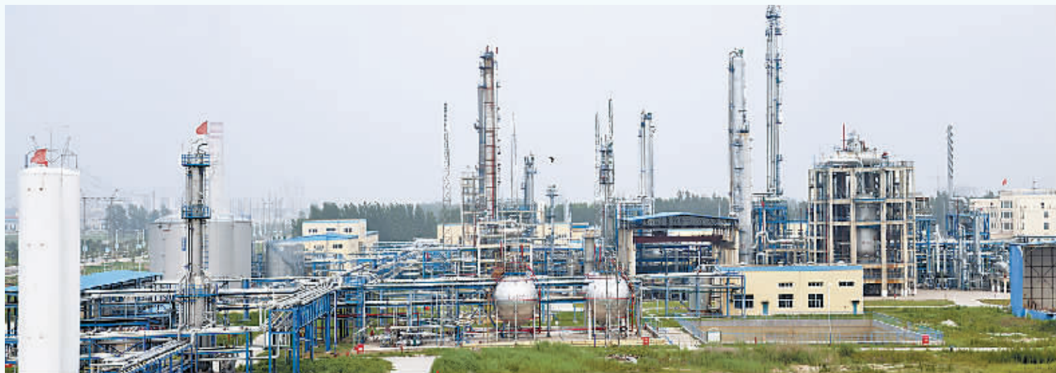
中亚化工： 中亚化工由郑州煤炭工业集团、商丘龙宇化工和中原腾达商贸联合承建，年产 12 万吨醇醚和 6 万吨环氧乙烷，项目被列为河南省“8511 工程”。
