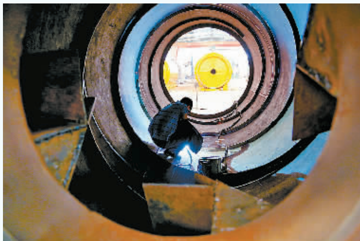
金源机械： 金源机械设备有限公司工人正在进行设备焊接。该公司是国内首家从事废旧资源（废塑料、废橡胶、废机油等）开发利用的专业机构，是国内独家采用水膜式脱硫除尘器的公司，现拥有国家专利14项。产品出口奥地利、波兰、土耳其、韩国、泰国、印度等国家。
