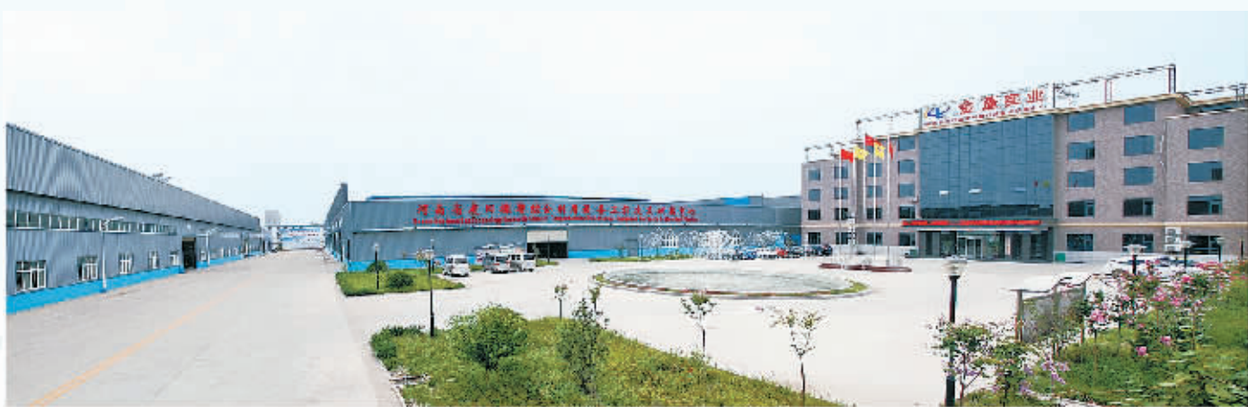
美丽的金蓬实业股份有限公司办公区。
