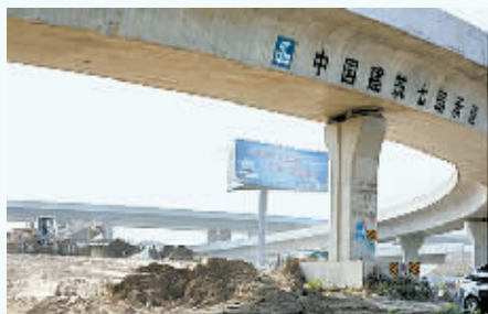
即将竣工的 310 国道与 105 国道交会的立交桥
