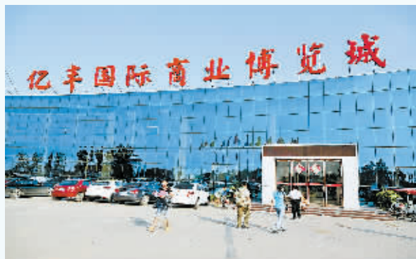
亿丰国际商业博览城：客户走进建设中的亿丰国际商业博览城项目。该项目由上海亿丰企业(集团)有限公司投资建设，是以建材家居、五金机电、饰品装饰、金属制品等为主的大型商业商贸物流博览城。总投资约 12 亿元，总建筑面积 30 万平方米，项目分三期建设，预计今年 8 月底一期主体结构全部封顶，计划年底试营业。商丘日报记者 崔申义 摄
