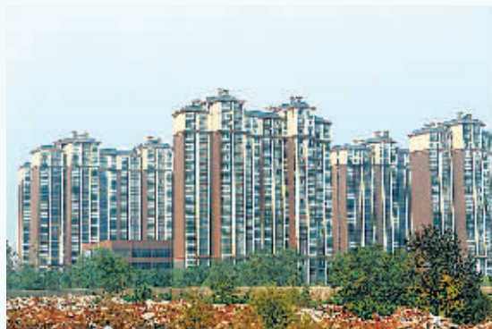
新落成的居民安置小区
