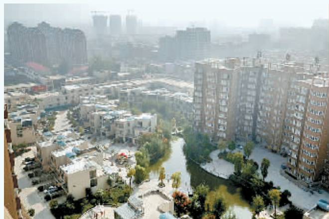
由连体洋房和小高层构成的高档住宅小区
