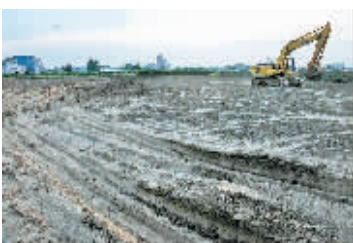
商务中心区引黄调蓄工程施工现场
