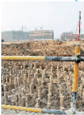
施工中的古城棚户区安置文/商丘日报记者 白鹏 摄
