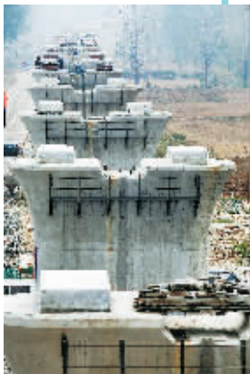
郑徐高铁正在施工
