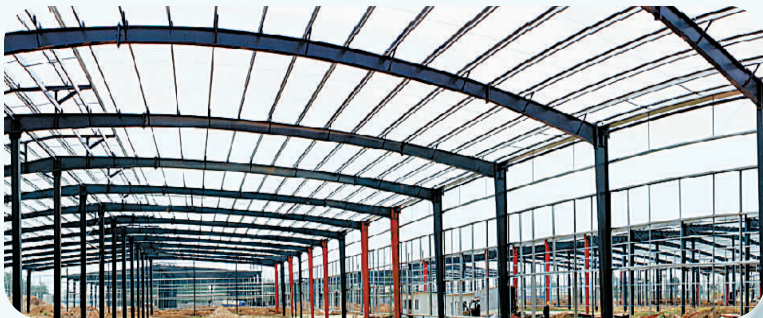
源龙集团：源龙（河南）项目工地正加紧施工。该项目是一家以制鞋企业为主的，辅以鞋材公司、鞋业进出口贸易公司等多元综合性发展的集团公司，该项目全部建成投产后，年实现销售收入18亿元，创利税9000余万元，提供就业岗位8000余个。
