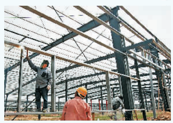
源龙鞋业施工现场
