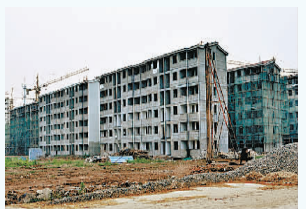
新景花园廉租房主体部分完工、部分在建
