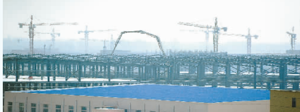
建设中的纺纱车间
