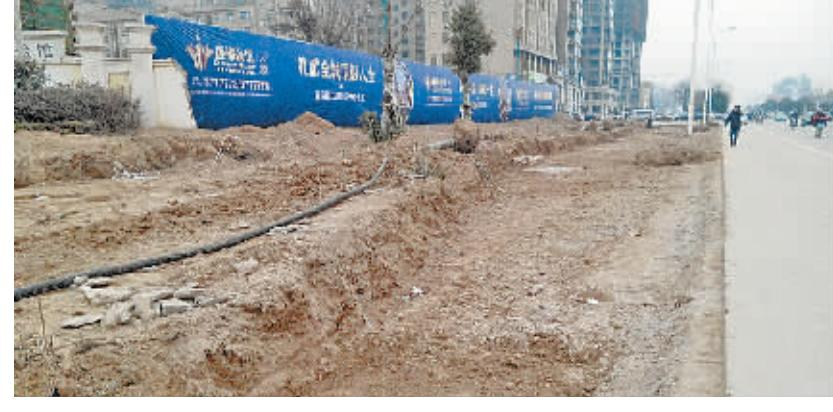
展的增速, 目前神火大道南段的道路设置已经难以满足高峰时段的需求。所以市政部门开始对北海路至华商大道之间的神火大道的规划车道进行完善。在现有车道不变的情况下, 将在东西两侧各修建一条6米宽的非机动车道和5米宽的人行道, 并且完善污水管网和其他地下管线的铺设。
