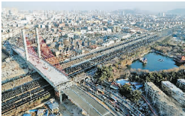
1月19日,山东省邹城市30米上跨京沪线转体桥成功转体97.3度与边跨现浇段合龙。据了解,转体桥横跨京沪铁路站场14股道线,全长1198.5米,主桥转体重量2.24万吨,是目前世界上最重的转体桥。
