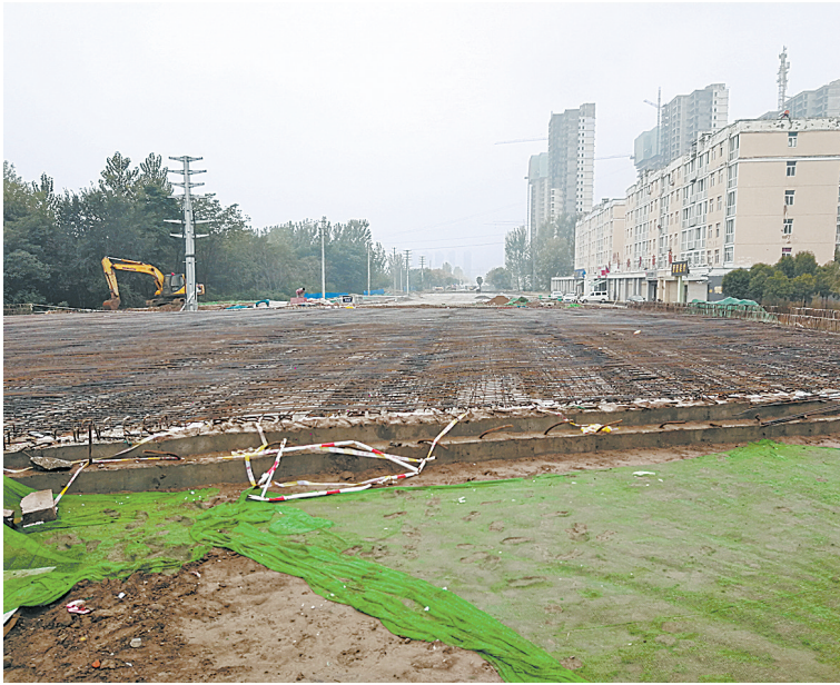
升级改造施工中的八一路
