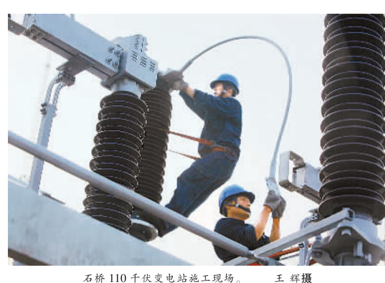
石桥110千伏变电站施工现场。王辉摄
