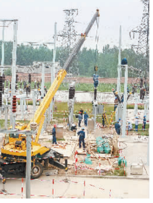
公司进行迎峰度夏工程施工。王辉摄
