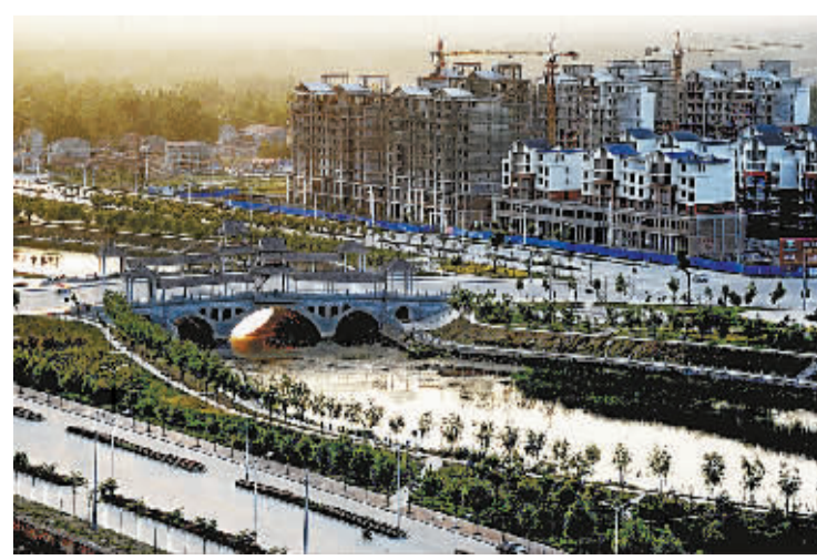
产业集聚区建设工地一角。
