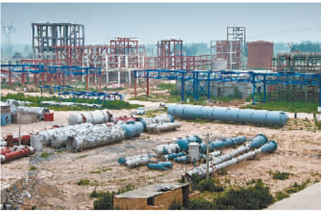
位于睢阳区产业集聚区内的中亚化工施工现场
