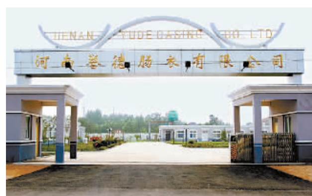
誉德公司肠衣加工厂区大门。
