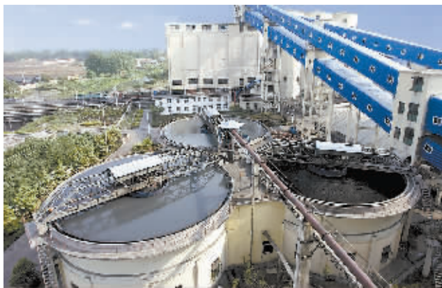
永煤集团现代化选煤厂场景。
