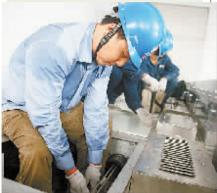
商丘供电公司员工冒高温检修设备。
