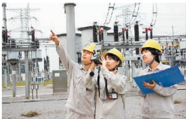
商丘供电公司举行大负荷冲击试验。
