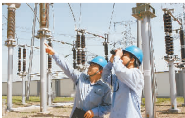
商丘供电公司排查设备隐患,确保迎峰度夏期间安全供电。
