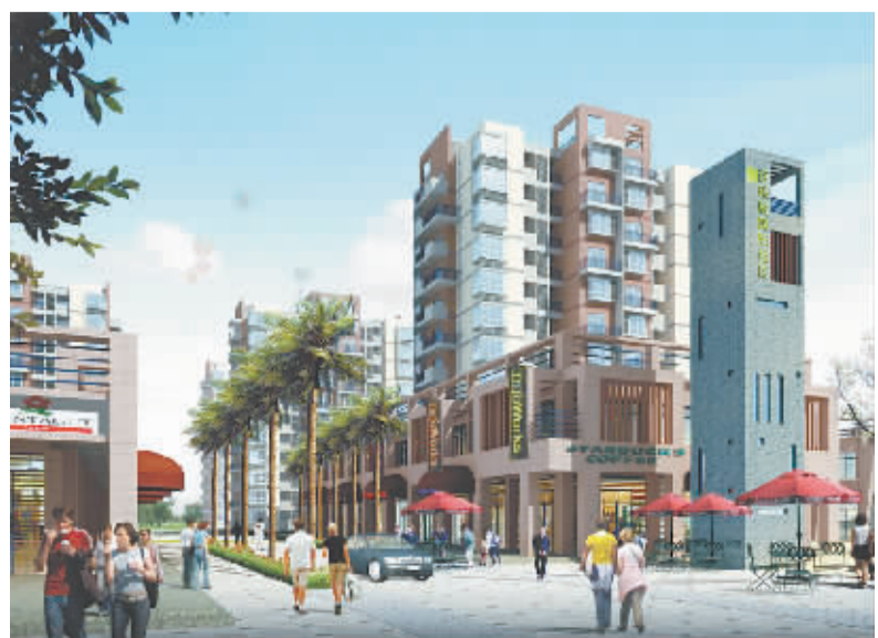
正在施工的百乐居小区。
