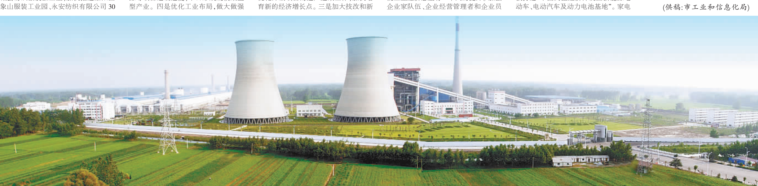
国家综合利用节能环保示范电站及铝产业园（神火集团）。
