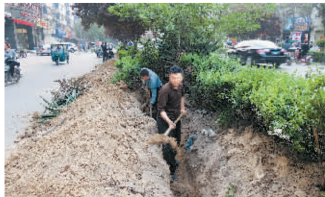
5月3日,在八一路,施工工人正在花坛里开沟,为线缆入地做准备。
