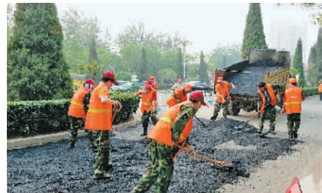
5月3日,施工工人正在为神火大道的部分路面“美容”,让车辆和行人能够更好地通行。
