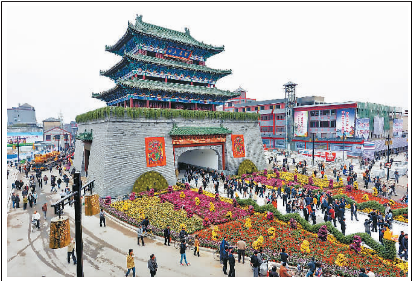
10月16日,市民和游客穿过开封鼓楼的拱形门洞,逛街赏景。当日,复建后的开封鼓楼正式开放迎接市民和游客。开封鼓楼,建于明洪武十二年(1379年),是中国最早的鼓楼之一。1948年毁于战火。2011年,开封宋都古城文化产业园区在园区规划中把鼓楼复建列为首批项目。经过一年半的施工建设,这一象征着古城风貌的标志性建筑终于重新矗立在世人眼前。复建后的鼓楼,高28.8米,共3层,一层城台有五米高的拱形门洞供车辆、行人通过,总体呈现明清建筑风格,成为古都开封的一张文化名片。
