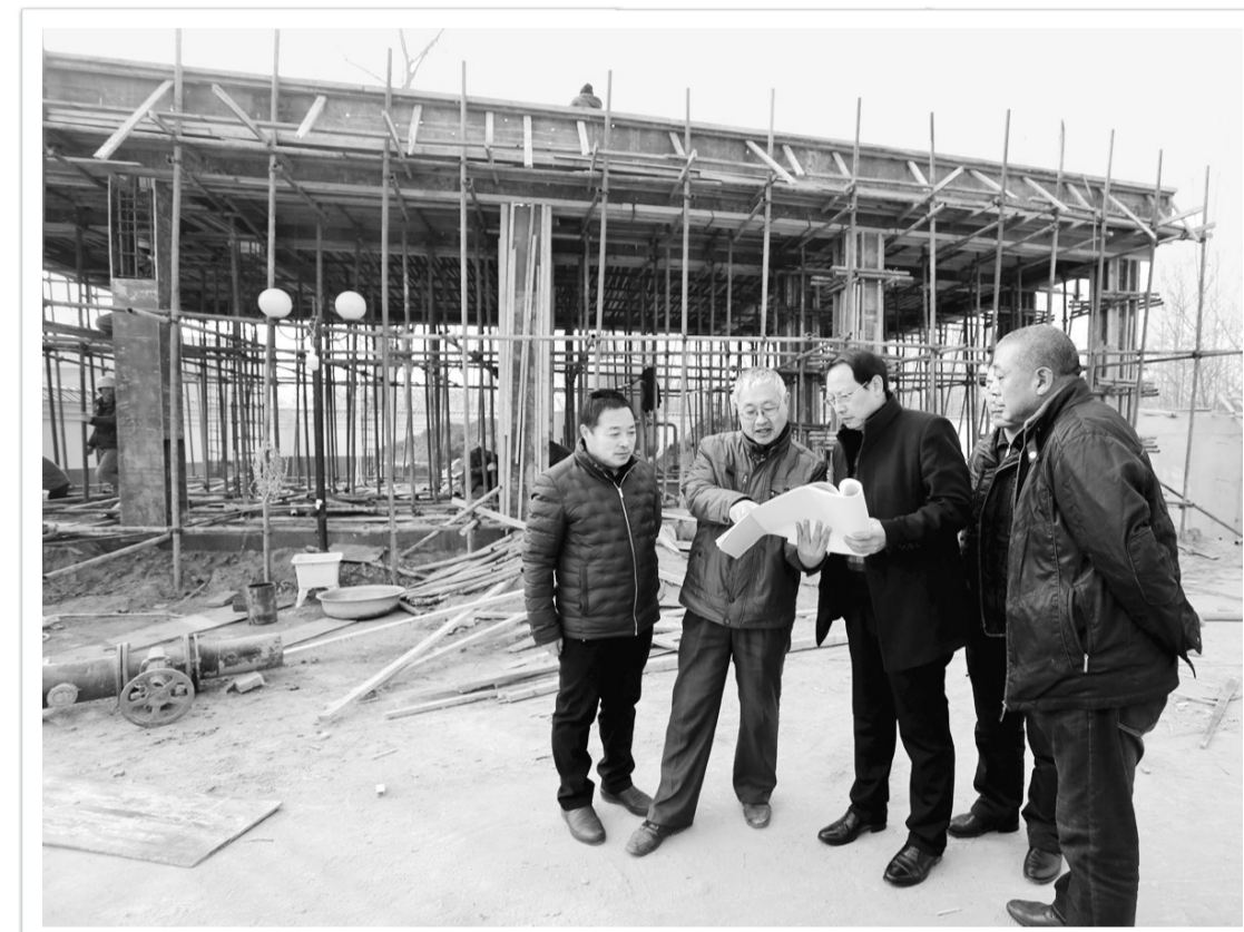
12月15日,宁陵县水利技术人员在阳驿乡检查农村安全饮水工程进度和质量。今年,该县着力加大农村安全饮水工程建设力度,加大投入和督查,力争使全县偏远农村广大群众能尽快吃上安全、清洁、干净的自来水。 吕忠籍摄
