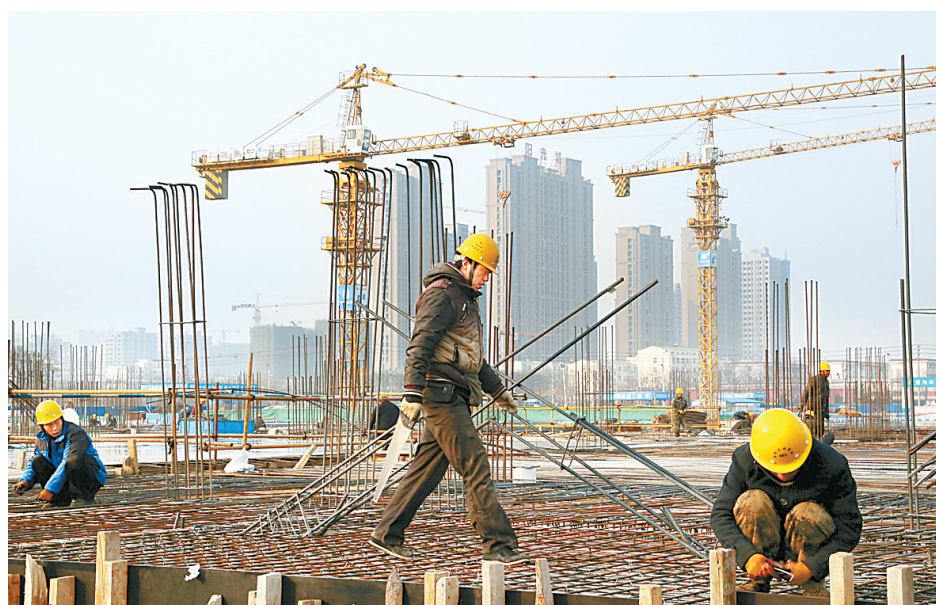
万达广场建设项目。
