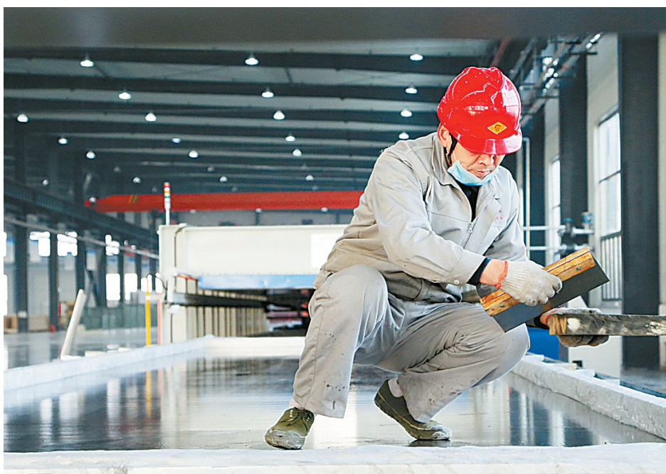
民权县澳柯玛冷藏车项目。
