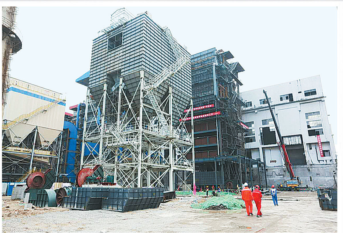
11月1日，丰源电厂新上锅炉岛项目正在紧张施工。据了解，丰源热电厂位于平原路，担负着我市城区集中供暖任务，新建锅炉岛完成后将有助于提高市区供暖效率。
