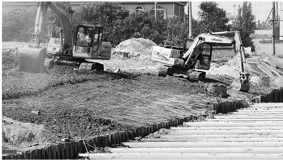
建设中的富商大道综合管廊工程。富商大道综合管廊全长4.4公里，沿线有北海路、珠江路、宇航路、南京路、淮河路、长江路、豫苑路、文化路、睢阳路等道路交通流量汇入，入廊管线为给水、供热、电力及信息管道。
