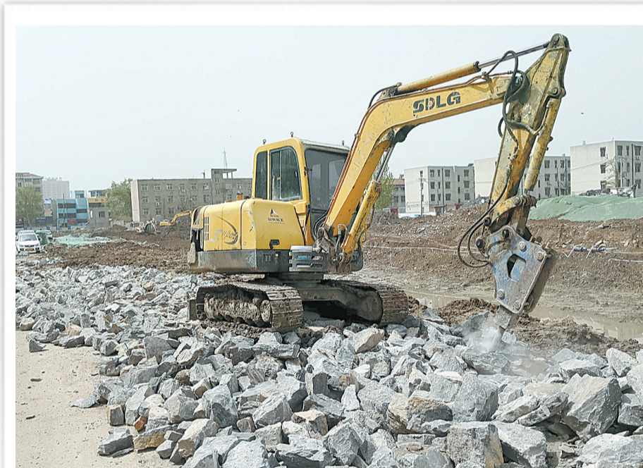
4月18日，大型机械正在我市南京路南侧忠民河综合治理项目以水文化、乡土文化、湿地景观、城市生态文明为特征，打造集城市绿地、滨水游览、运动休闲、文化展示等功能为一体的新型城市生态游憩系统。本报记者 崔坤 摄
