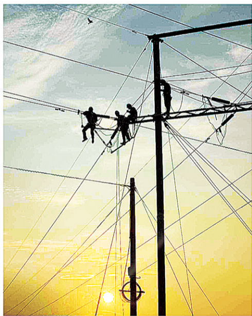
电网建设施工
