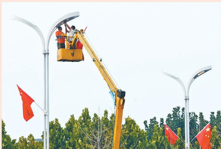
9月25日，电力工人在对中州路LED路灯进行维护。国庆节临近，市城市照明管理处加大对主干道、人流密集区域的照明设施排查检修力度，确保国庆节期间路灯设施功能完好，保障市民出行安全。
