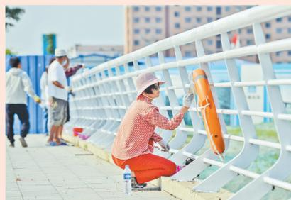
9月25日，在星林路包河桥上，工人对桥两侧的护栏进行上漆保养，防止栏杆生锈，提升桥梁景观效果。
