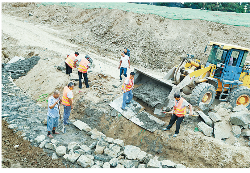
10月16日,民权县东水水系项目工程正在加紧实施之中。今年年初以来,该县进一步加大水生态治理项目实施力度,他们以生态城市和海绵城市为设计理念,城区重新规划建设“九河五湖三湿地”河湖水系,建成后黑臭水体治理、老旧城区改造、城市园林绿化、生态环境涵养等多项任务实现有机整合,群众的生活质量将大大提高。
