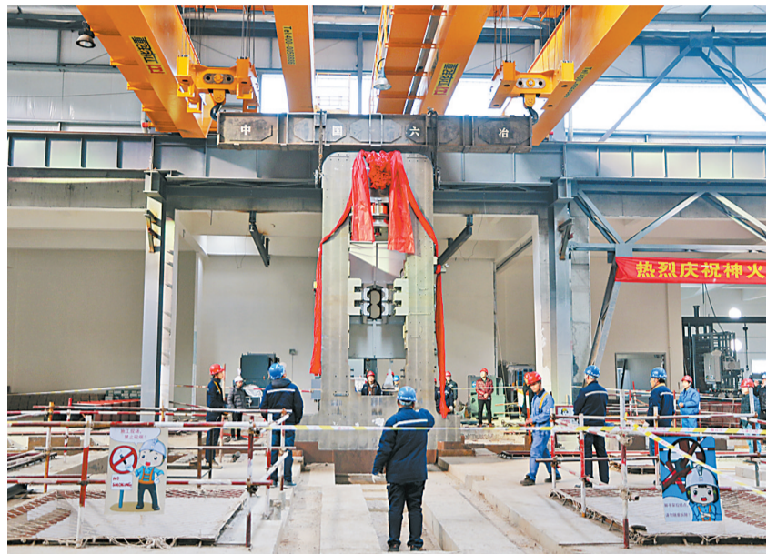
神隆宝鼎新材料有限公司技术人员与安装单位、德国设备专家一起,对粗轧机牌坊吊装做最后的准备工作。
