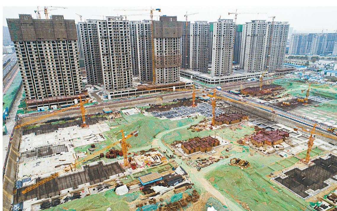
12月8日,航拍建设中的和飞社区棚户区改造项目。位于包河以南、方域路以北、豫苑路以东、星林路以西的示范区和飞社区总投资23.1亿元,规划建筑面积82.1万平方米,可安置5282户群众。目前项目一期主体建筑已完工,二期正在进行主体浇筑施工。
