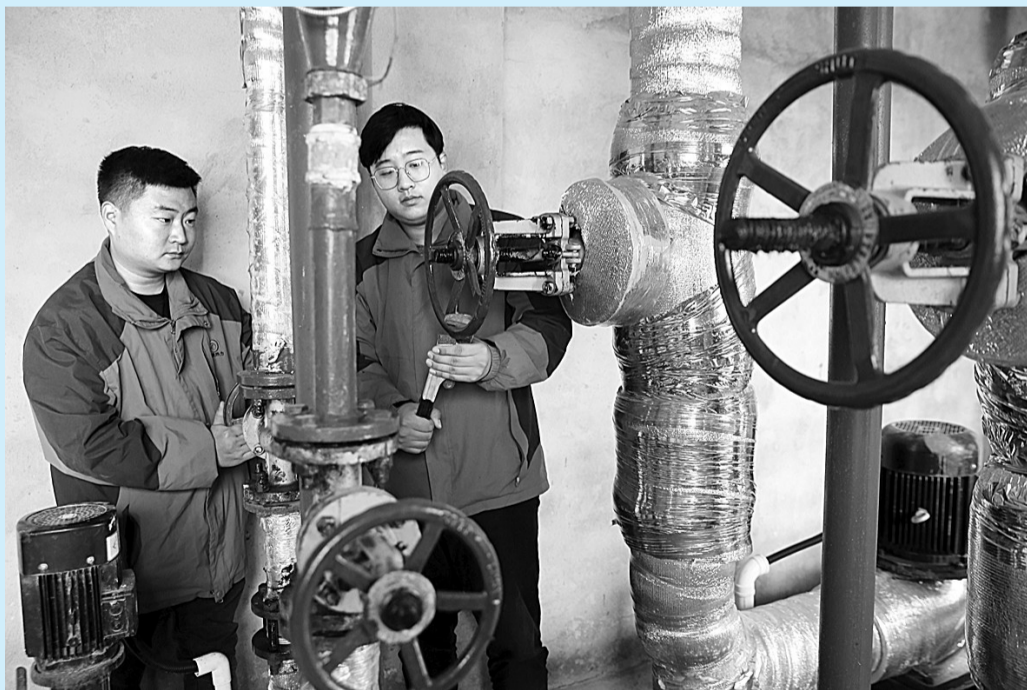
10月11日,在示范区米兰花园小区供暖换热站内,恒源热力有限公司开发区热力所工作人员正在进行检修。距离今冬采暖期还有一个多月,我市热力部门组织人员全力做好巡检、检修、技改工作,为今冬供暖工作奠定良好基础。 本报记者 邢栋 摄
