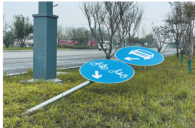
10月10日,在全桥路与梁园路交叉西北角,一处交通指示牌受损倒伏。 本报记者 崔坤摄
