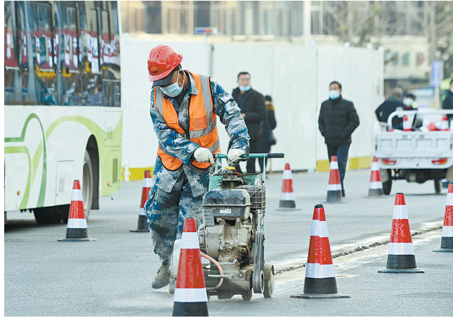
1月3日，施工人员在商丘火车站南广场施工。为了缓解交通拥挤，确保“春运”期间公交车辆和人流有序通行，商丘火车站南广场正在安装新的护栏，新护栏安装后将更加方便快捷进站和车辆通行。
