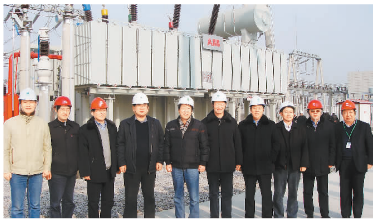
2008年12月27日,商丘220千伏迎宾变电站投运,省电力公司领导同商丘供电公司领导合影留念(左三:商丘供电公司总经理张道乾;右四:商丘供电公司党委书记夏绍锋;右一:商丘供电公司副总经理原水清)。
