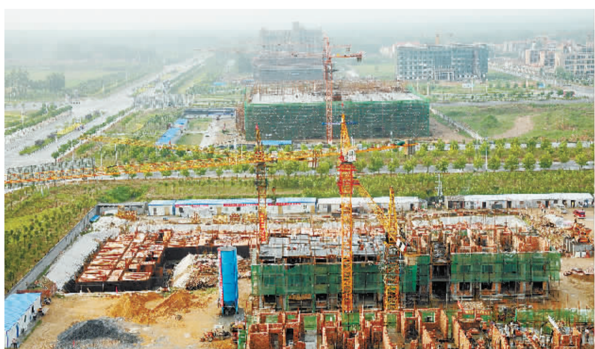
日新月异的民权新区工地。
