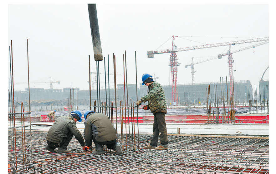
中原佳海国际商贸城项目施工现场。该项目规划总占地1515亩,总建筑面积约200万平方米,项目总投资约达80亿元人民币。目前,一期东区23万平方米建筑主体基本完工。本报记者 马晓伟 摄
