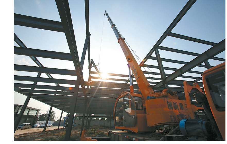
才华物储项目施工现场。本报记者 傅青 摄
