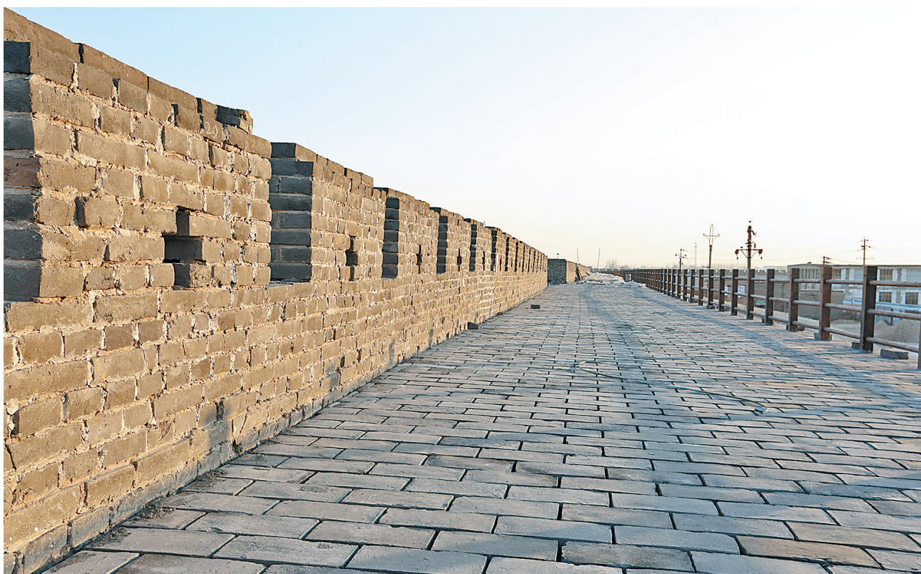
修复后的城墙。
